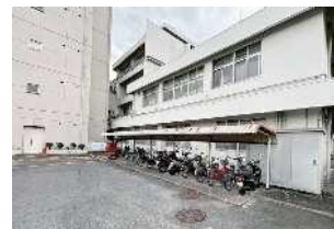
第一駐車場に救急車の車寄せと入口を新設
