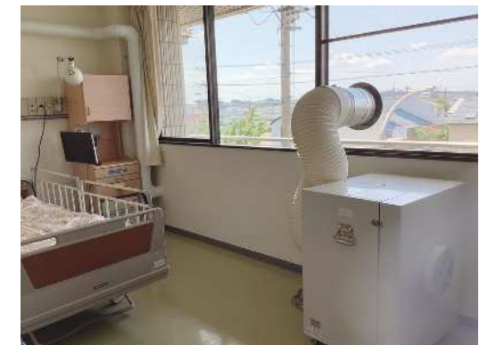
簡易陰圧装置が設置された病室
